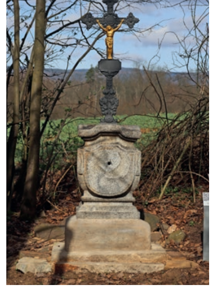
Křížek před Mořičovem po obnově, 17. 3. 2024, foto: J. Macke
