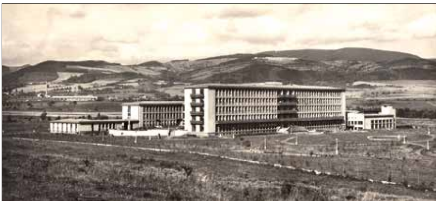
Nemocnice Ostrov na dobové pohlednici, sbírka Josef Macke
