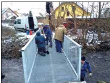
V Ostrově byla vyměněna lávka přes Jáchymovský potok
