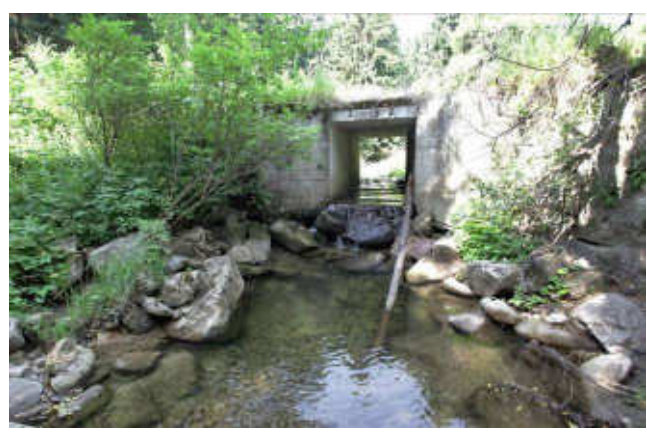
pohled z dolní vody na objekt
