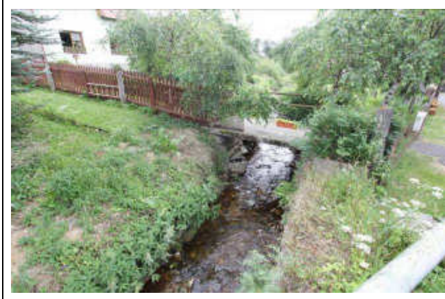
pohled z horní vody na objekt
