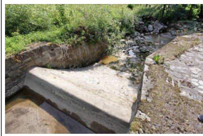
pohled z horní vody na objekt
