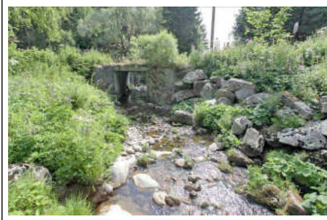
pohled z horní vody na objekt
