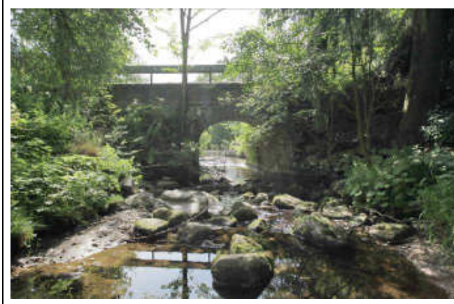
pohled z horní vody na objekt
