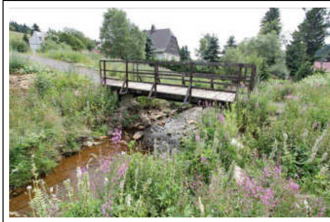
pohled z horní vody na objekt
