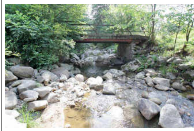
pohled z horní vody na objekt
