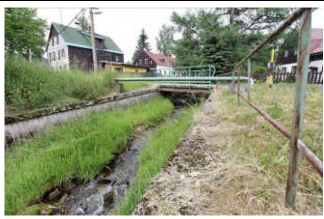
pohled z dolní vody na objekt
