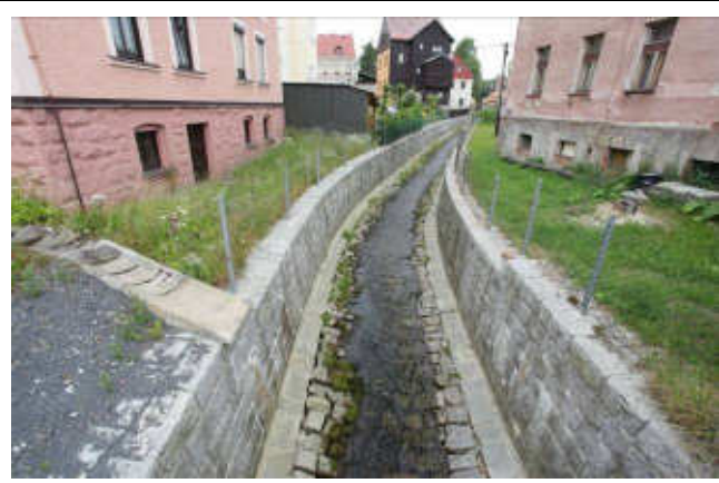
pohled na koryto z (od) objektu proti vodě
