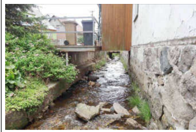
pohled z horní vody na objekt
