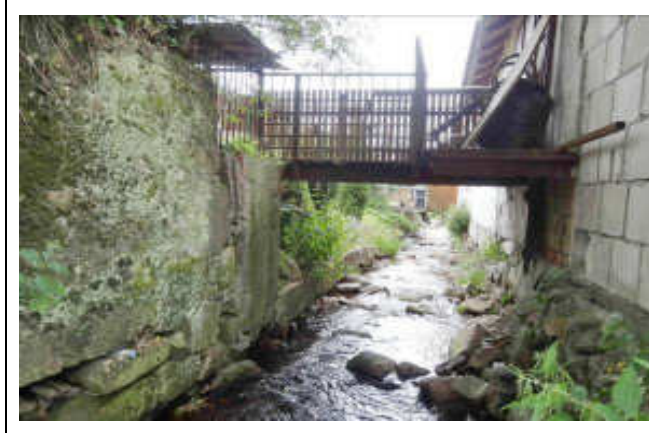
pohled z horní vody na objekt
