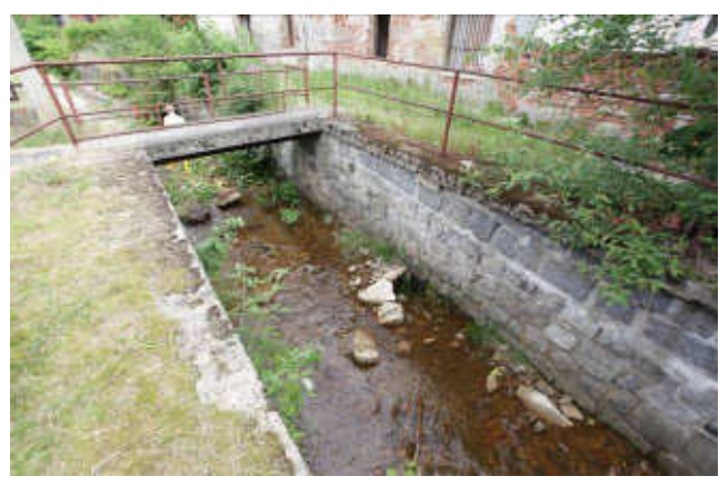
pohled z dolní vody na objekt
