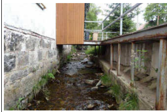
pohled z dolní vody na objekt
