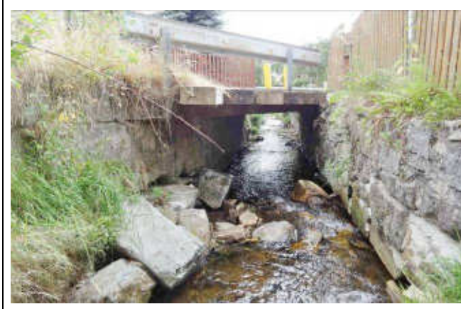
pohled z horní vody na objekt
