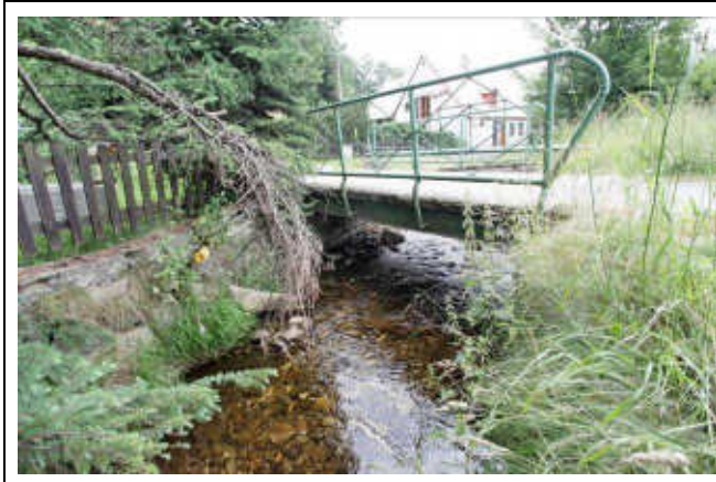
pohled z horní vody na objekt
