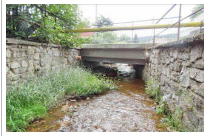
pohled z horní vody na objekt
