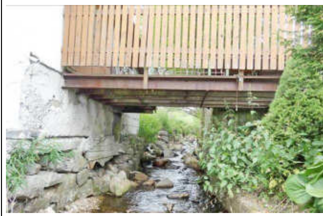
pohled z dolní vody na objekt
