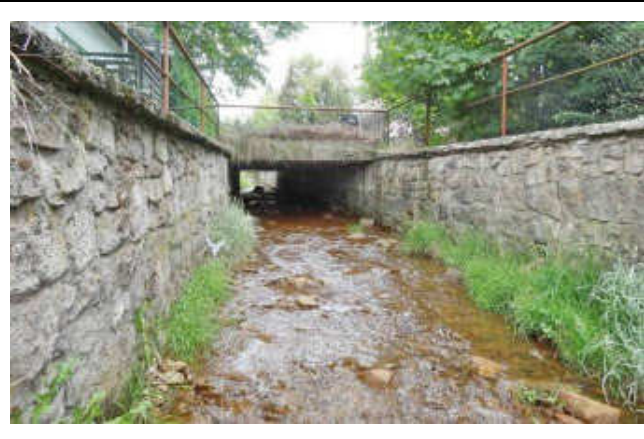
pohled z dolní vody na objekt
