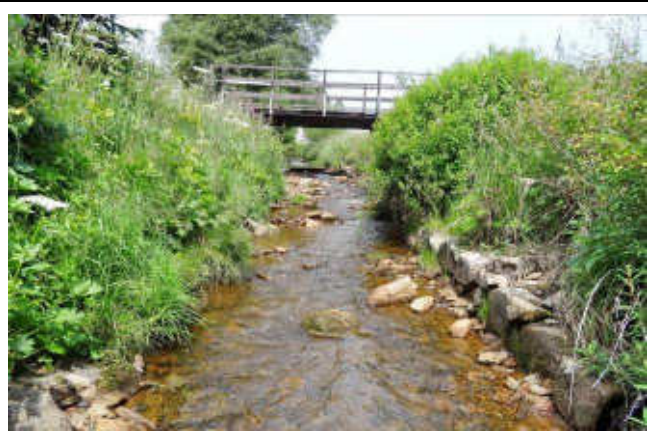
pohled z dolní vody na objekt
