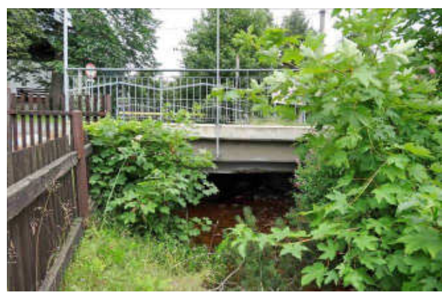
pohled z dolní vody na objekt
