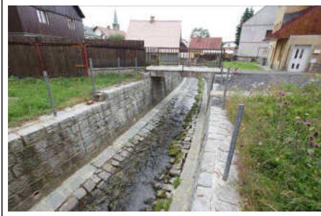
pohled z horní vody na objekt
