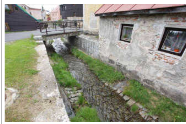
pohled z horní vody na objekt
