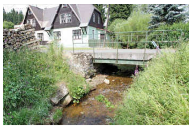
pohled z dolní vody na objekt
