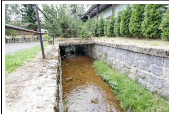
pohled z horní vody na objekt
