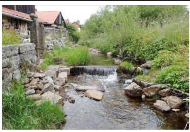
pohled z dolní vody na objekt
