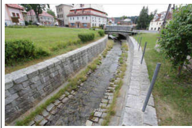
pohled z horní vody na objekt
