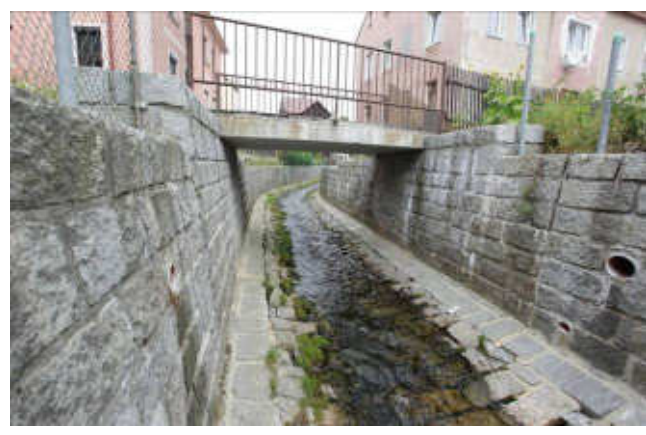
pohled z dolní vody na objekt
