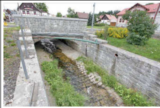
pohled z dolní vody na objekt
