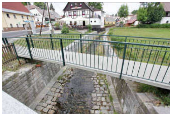
pohled z dolní vody na objekt
