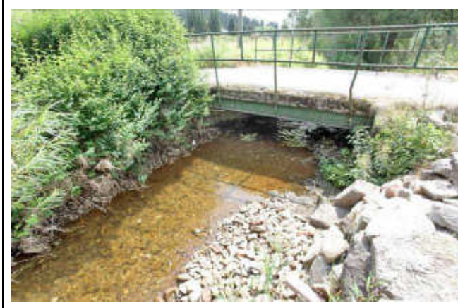
pohled z horní vody na objekt
