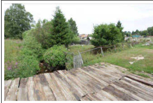
pohled z horní vody na objekt
