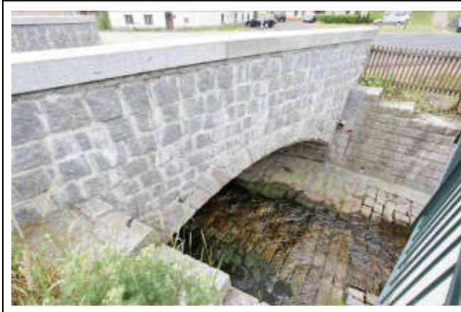
pohled z horní vody na objekt
