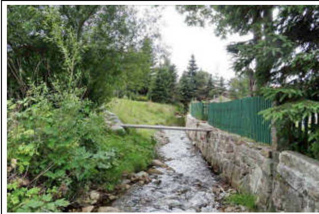
pohled z horní vody na objekt
