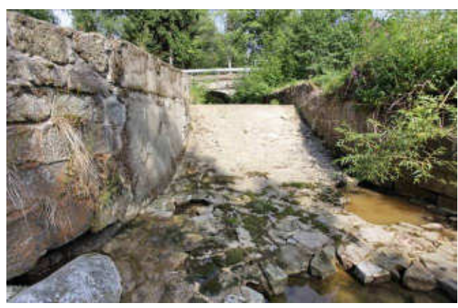
pohled z dolní vody na objekt
