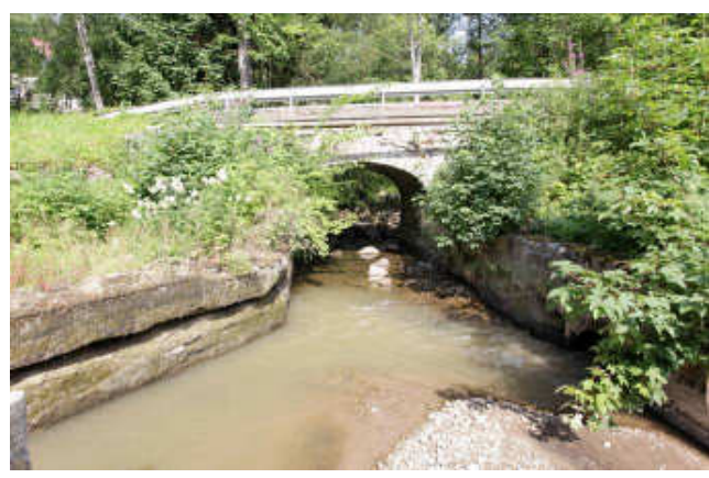
pohled z dolní vody na objekt
