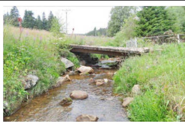
pohled z dolní vody na objekt
