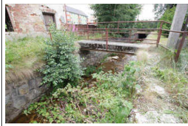
pohled z horní vody na objekt
