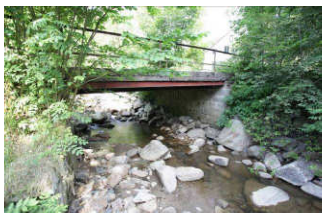
pohled z dolní vody na objekt
