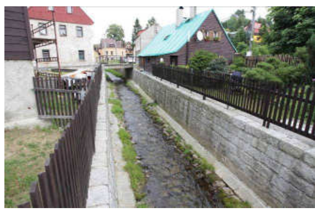
pohled z dolní vody na objekt
