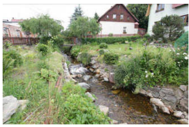
pohled z dolní vody na objekt
