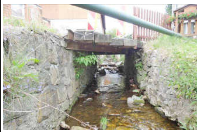
pohled z dolní vody na objekt
