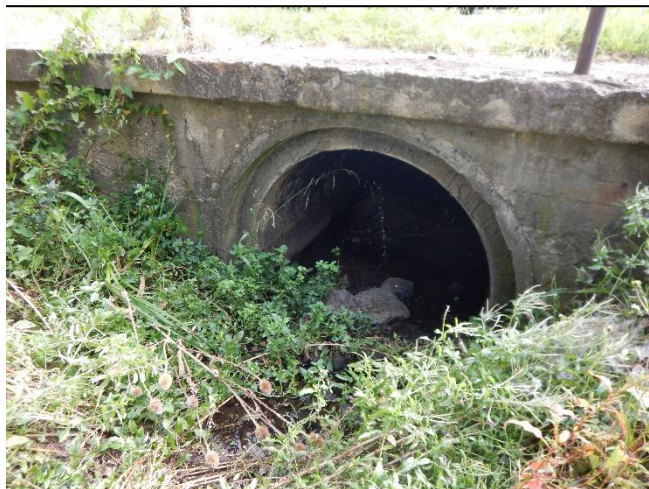
pohled z horní vody na objekt
