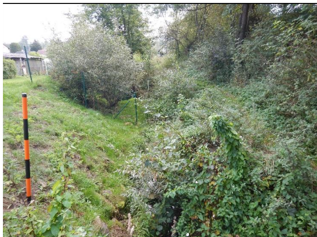
pohled na koryto z (od) objektu po vodě
