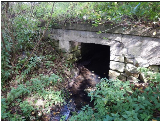
pohled z horní vody na objekt
