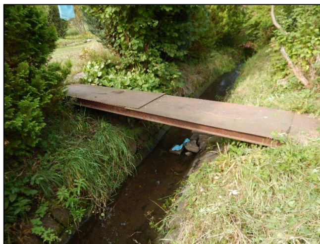
pohled z dolní vody na objekt
