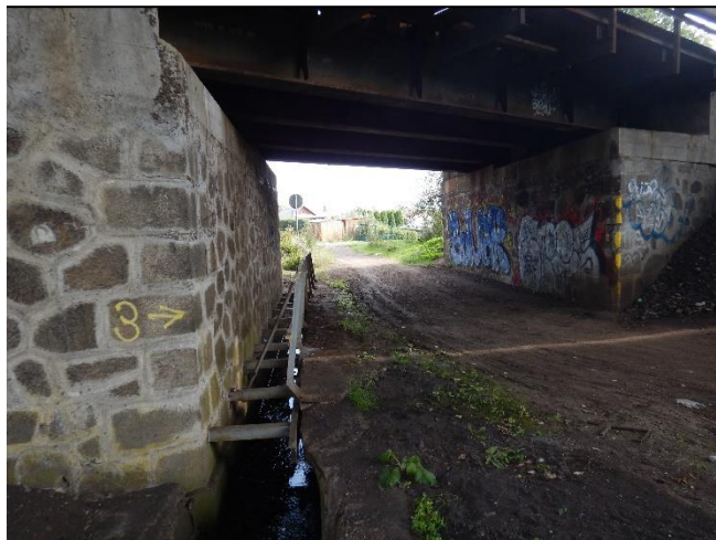
pohled z horní vody na objekt
