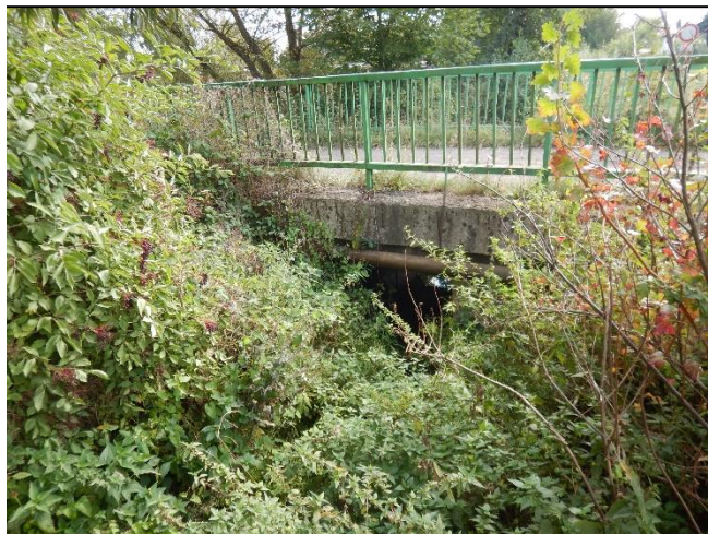
pohled z horní vody na objekt
