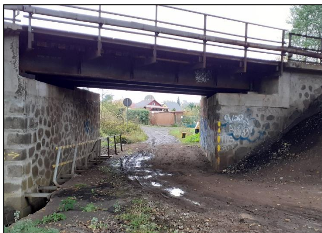
Celkový pohled na objekt
