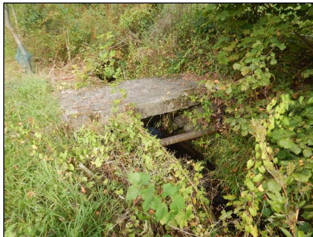
pohled z dolní vody na objekt
