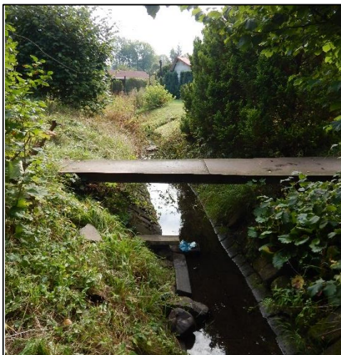
pohled z horní vody na objekt
