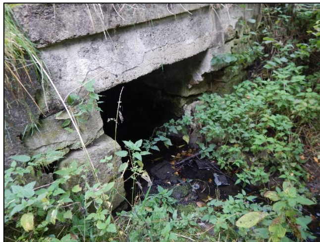
pohled z dolní vody na objekt
