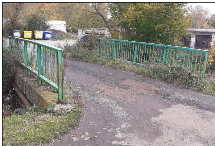
Celkový pohled na objekt
