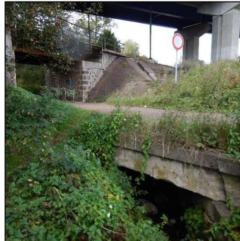
pohled z dolní vody na objekt
