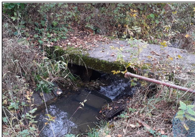
Celkový pohled na objekt
