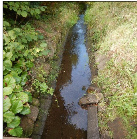
pohled na koryto z (od) objektu proti vodě
