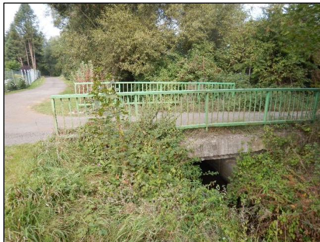
pohled z dolní vody na objekt
