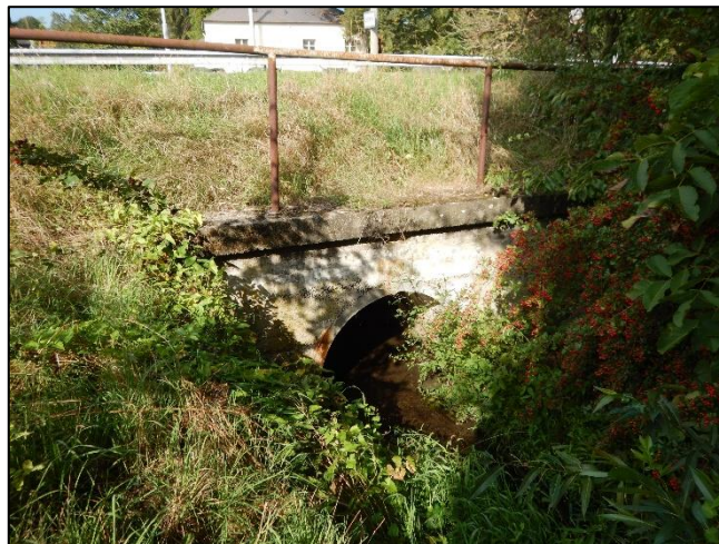
pohled z dolní vody na objekt
