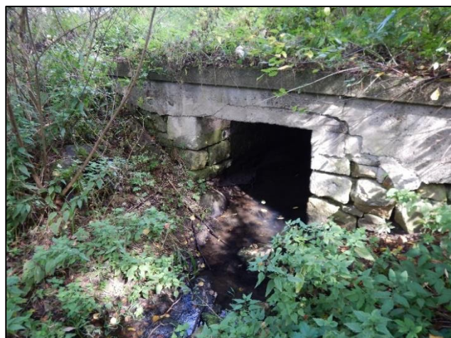
Celkový pohled na objekt
