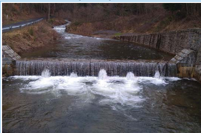
Pohled z dolní vody na objekt
