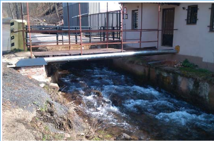
Pohled z dolní vody na objekt
