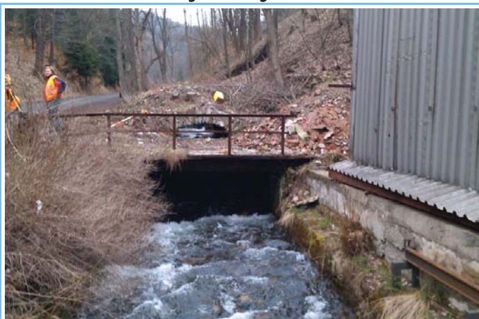
Pohled z dolní vody na objekt
