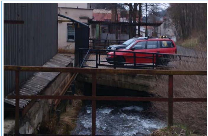
Pohled na koryto z (od) objektu po vodě
