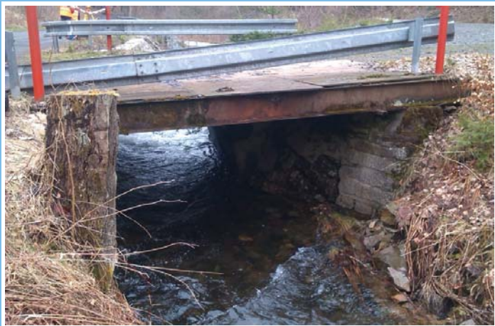
Pohled z dolní vody na objekt
