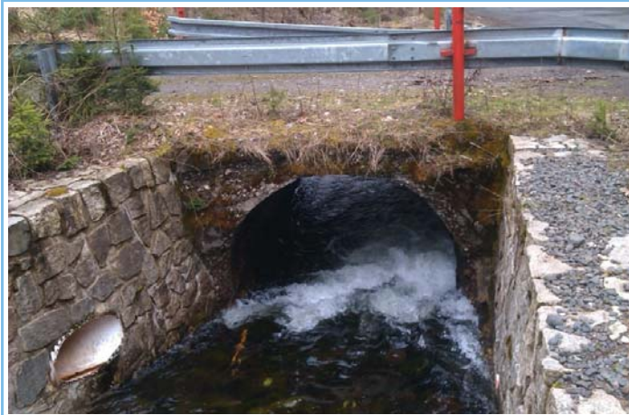
Pohled z horní vody na objekt
