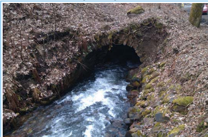
Pohled z horní vody na objekt
