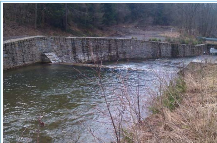
Pohled z horní vody na objekt
