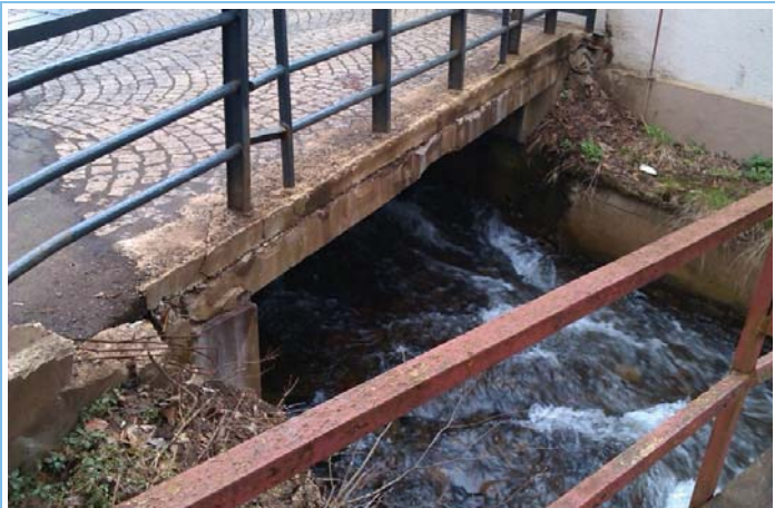
Pohled z dolní vody na objekt
