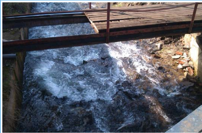
Pohled z horní vody na objekt
