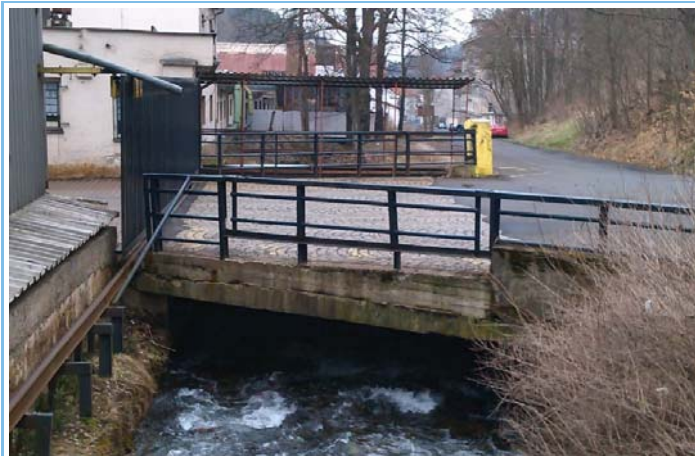
Pohled z horní vody na objekt
