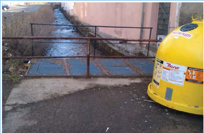
Pohled z dolní vody na objekt
