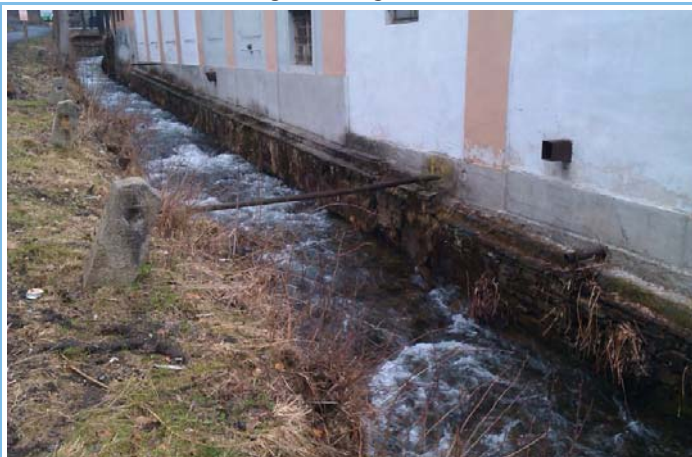
Pohled z dolní vody na objekt
