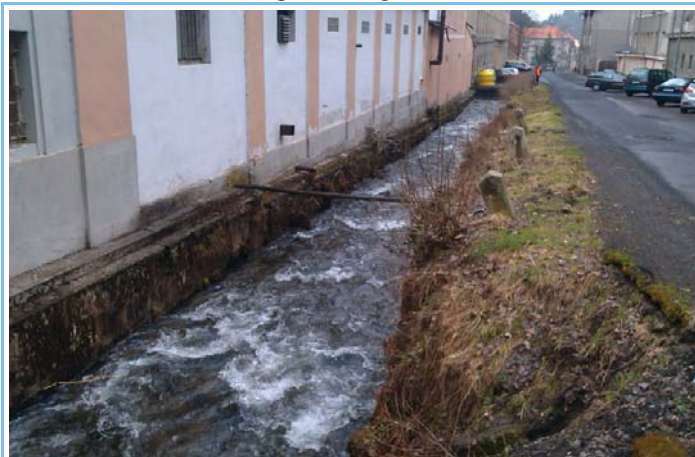
Pohled z horní vody na objekt
