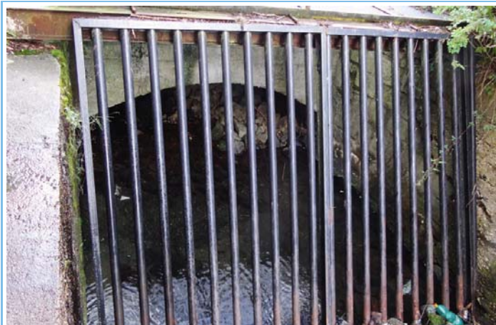
Pohled z horní vody na objekt
