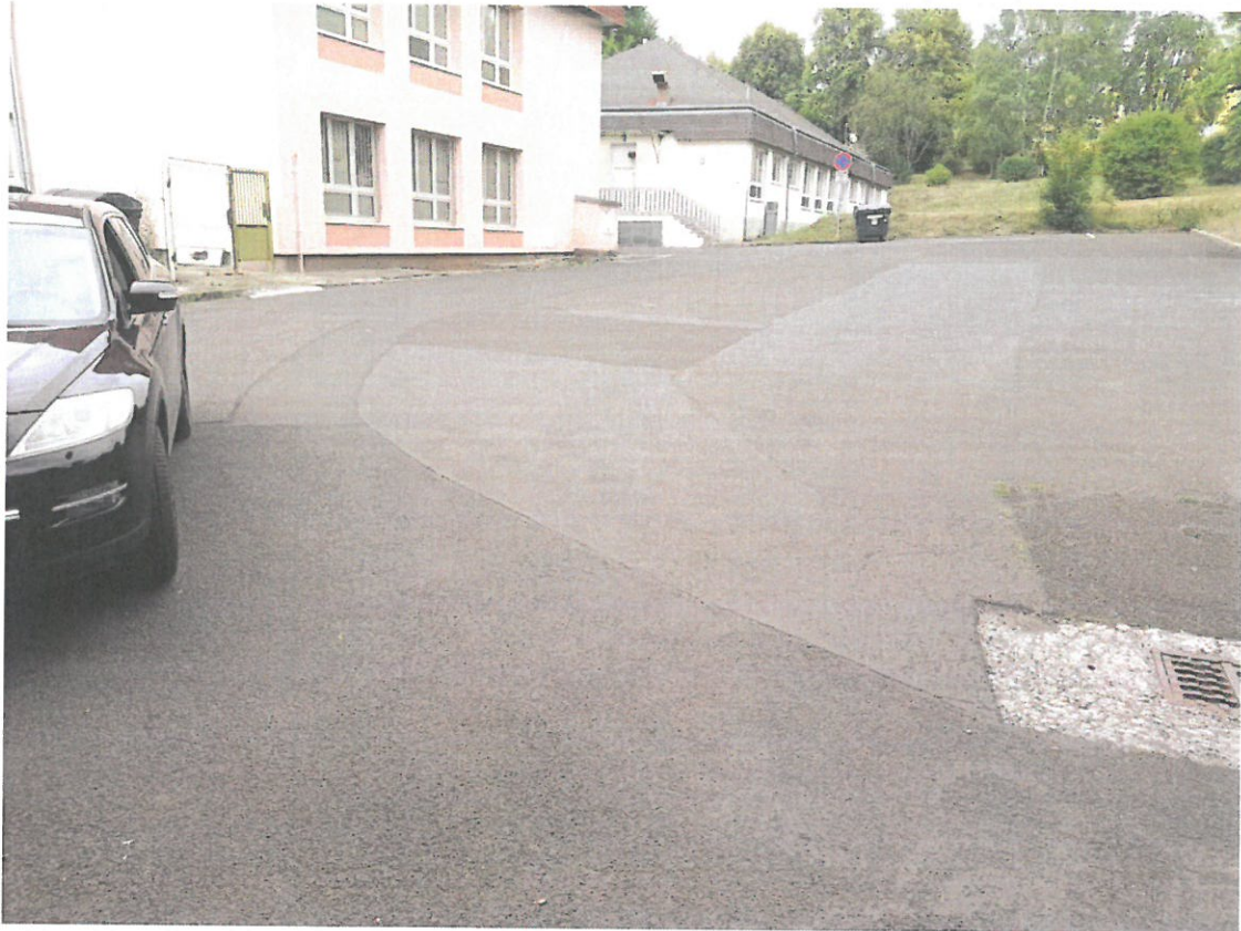
Obr. č. 8 – Foto stávající stav:
