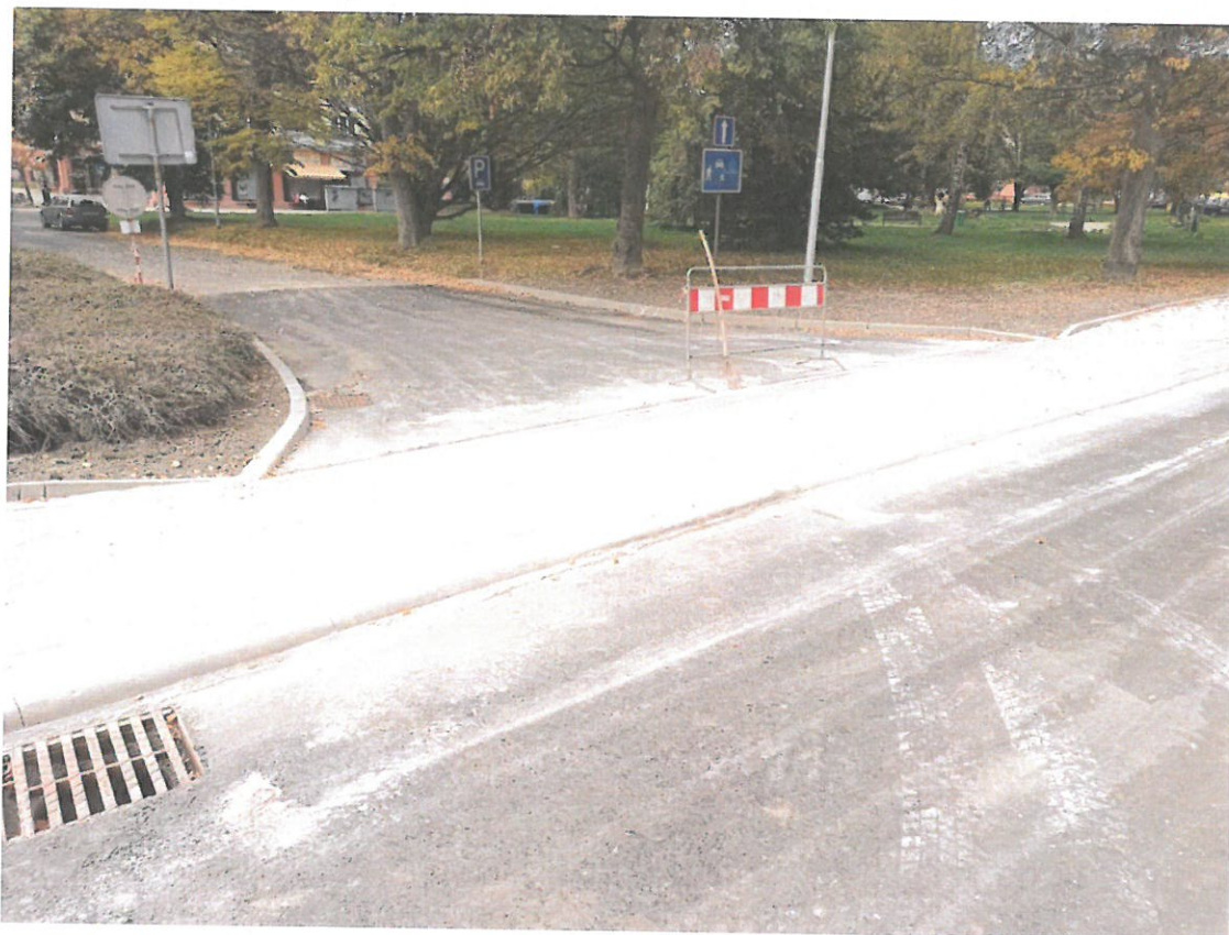
Obr. č. 11 – Foto stávající stav:
