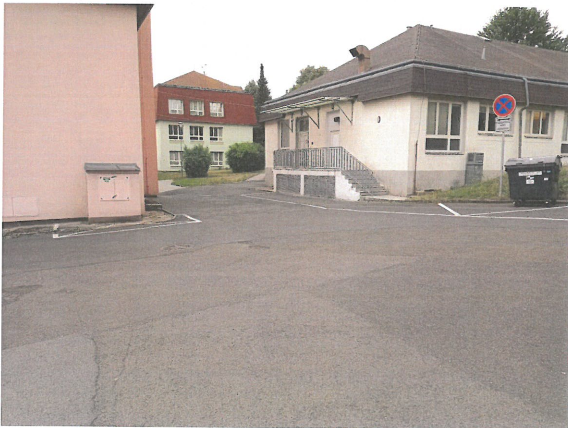
Obr. č. 9 – Foto stávající stav:
