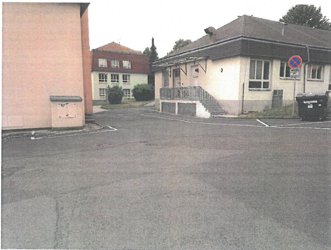
Obr. č. 9 – Foto stávající stav:
