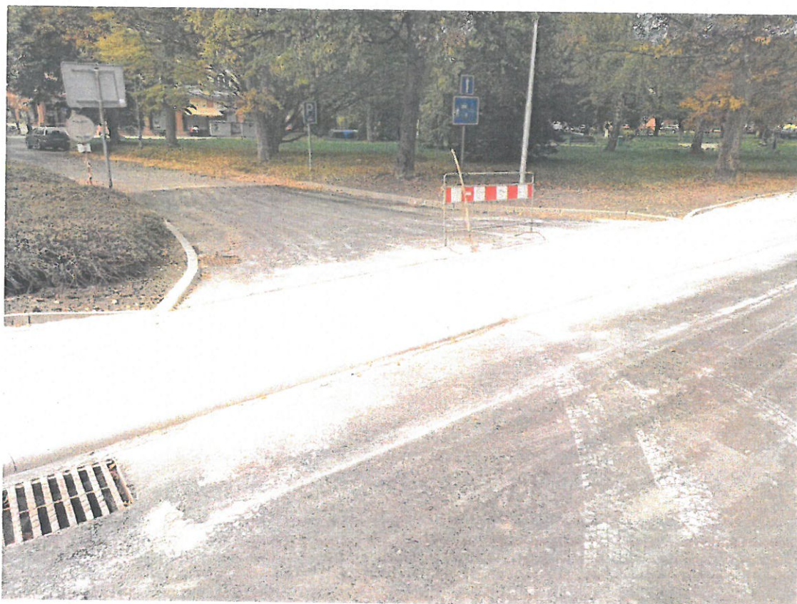
Obr. č. 11 – Foto stávající stav:
