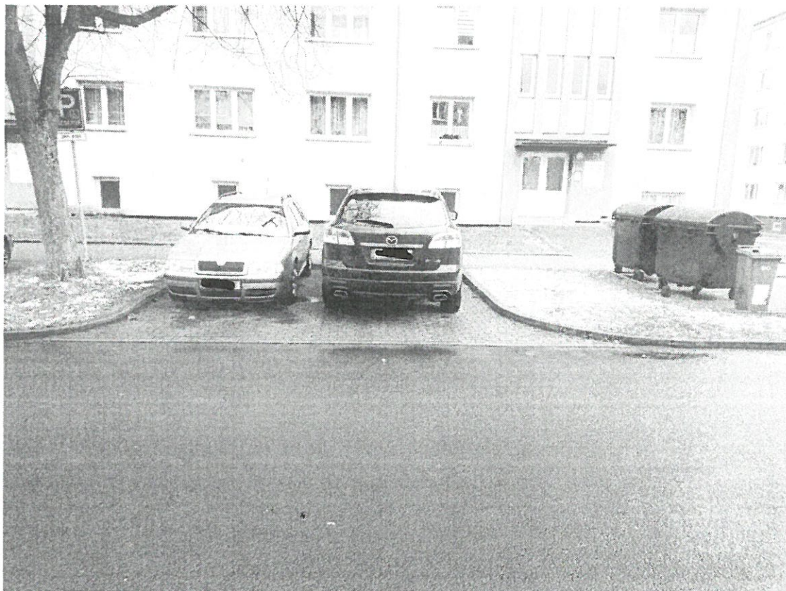
Obr. č. 3 – Foto stávající stav:
