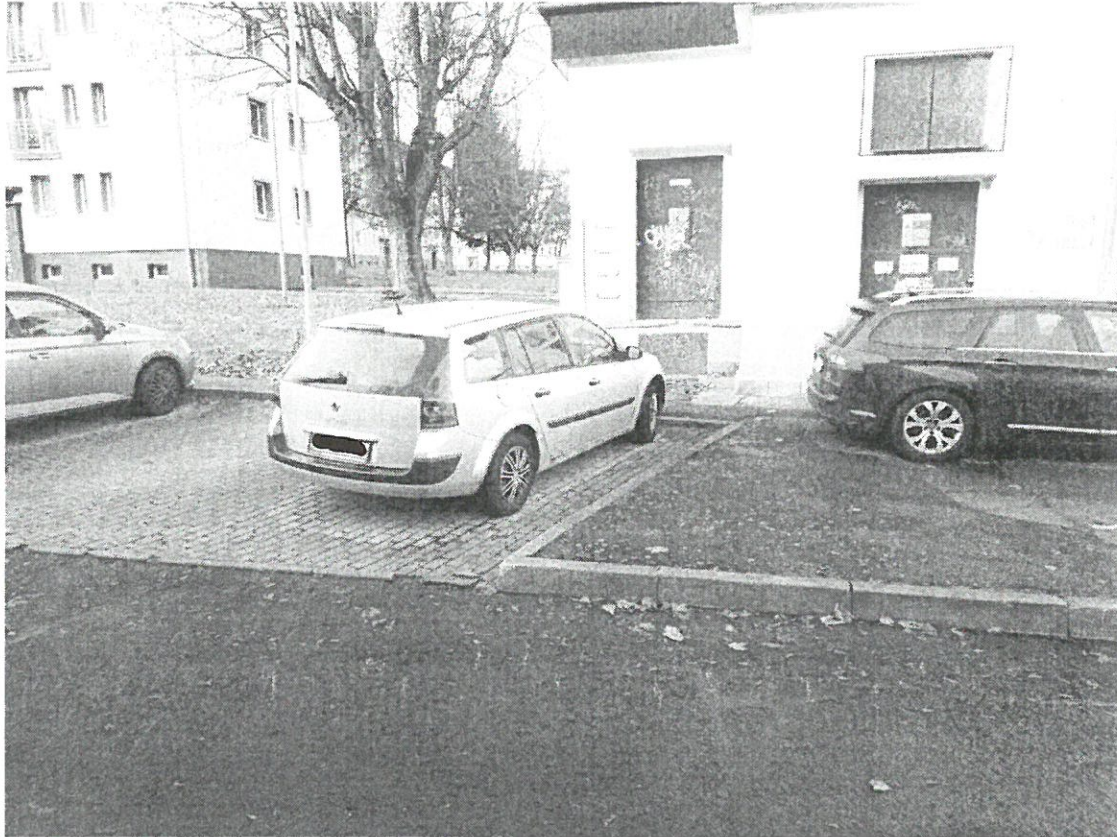
Obr. č. 1 – Foto stávající stav:
