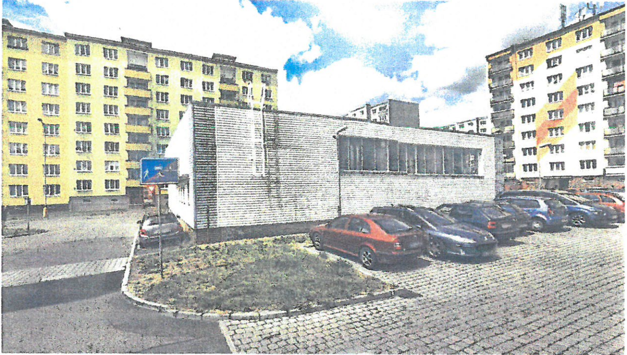
Obr. č. 11 – Foto stávající stav:
