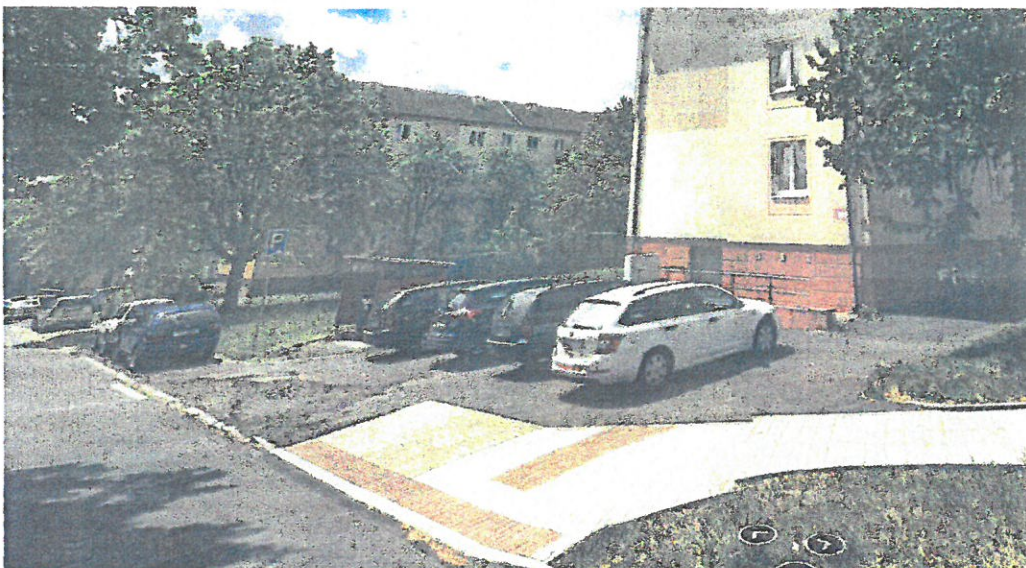
Obr. č. 5 – Foto stávající stav:
