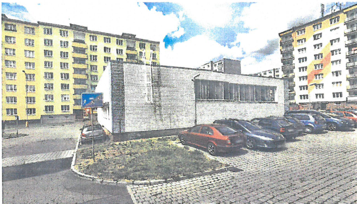
Obr. č. 11 – Foto stávající stav:
