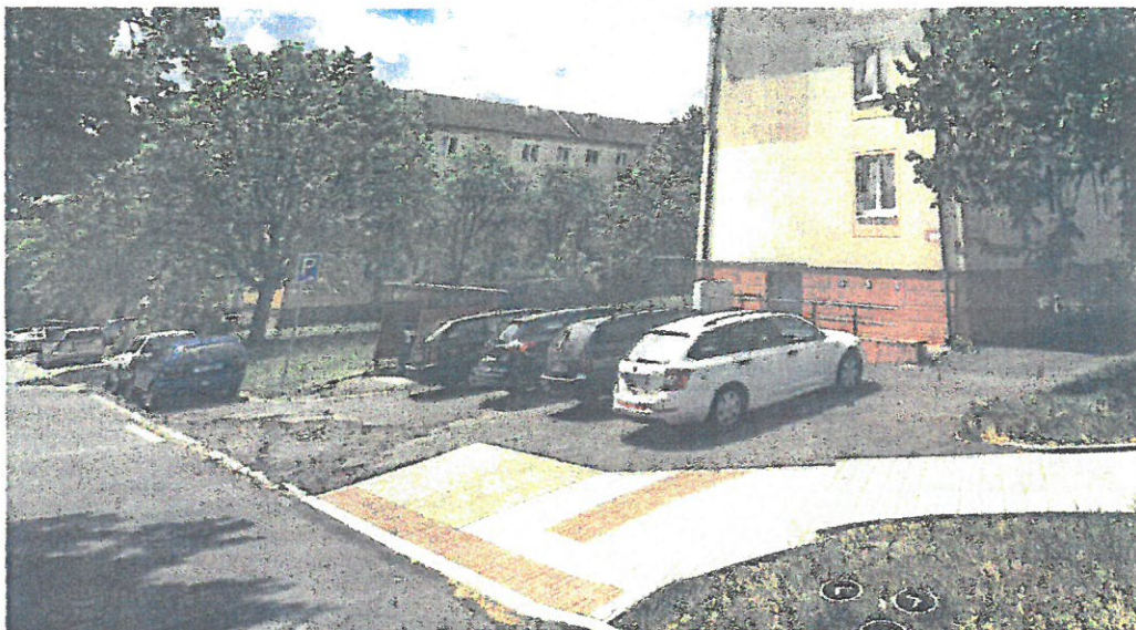
Obr. č. 5 – Foto stávající stav:
