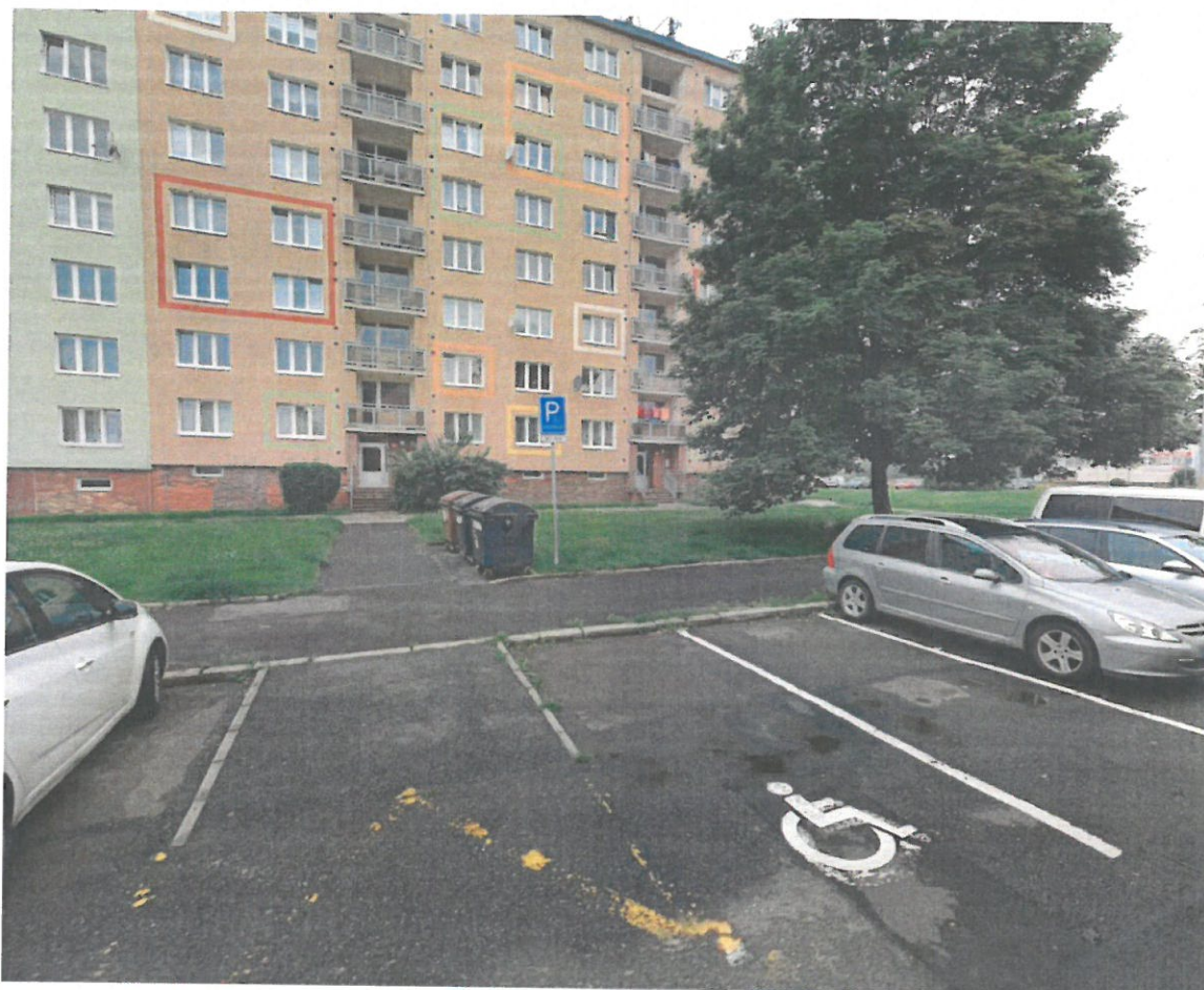
Obr. č. 3 – Foto stávající stav:
