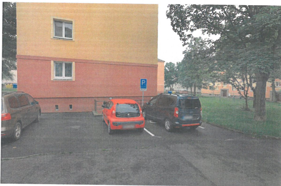
Obr. č. 1 – Foto stávající stav:
