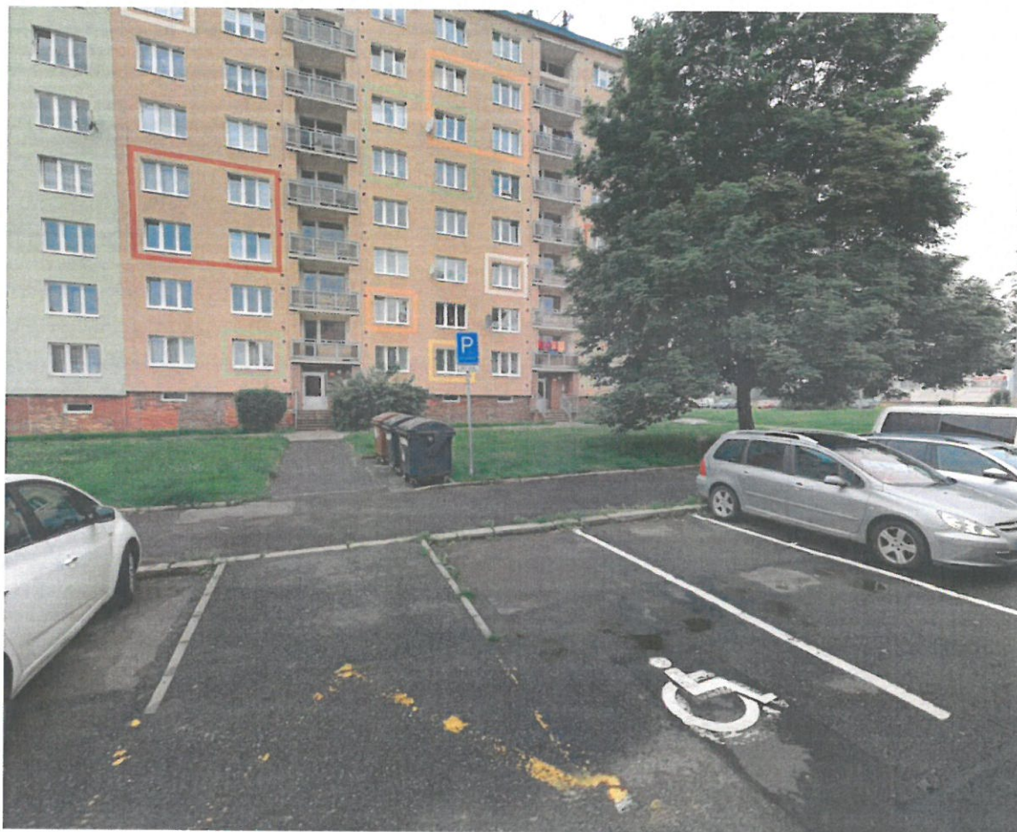
Obr. č. 3 – Foto stávající stav:
