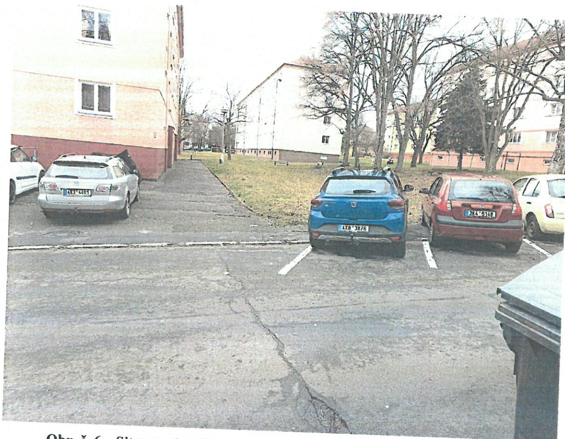
Obr. č. 5 – Foto stávající stav:
