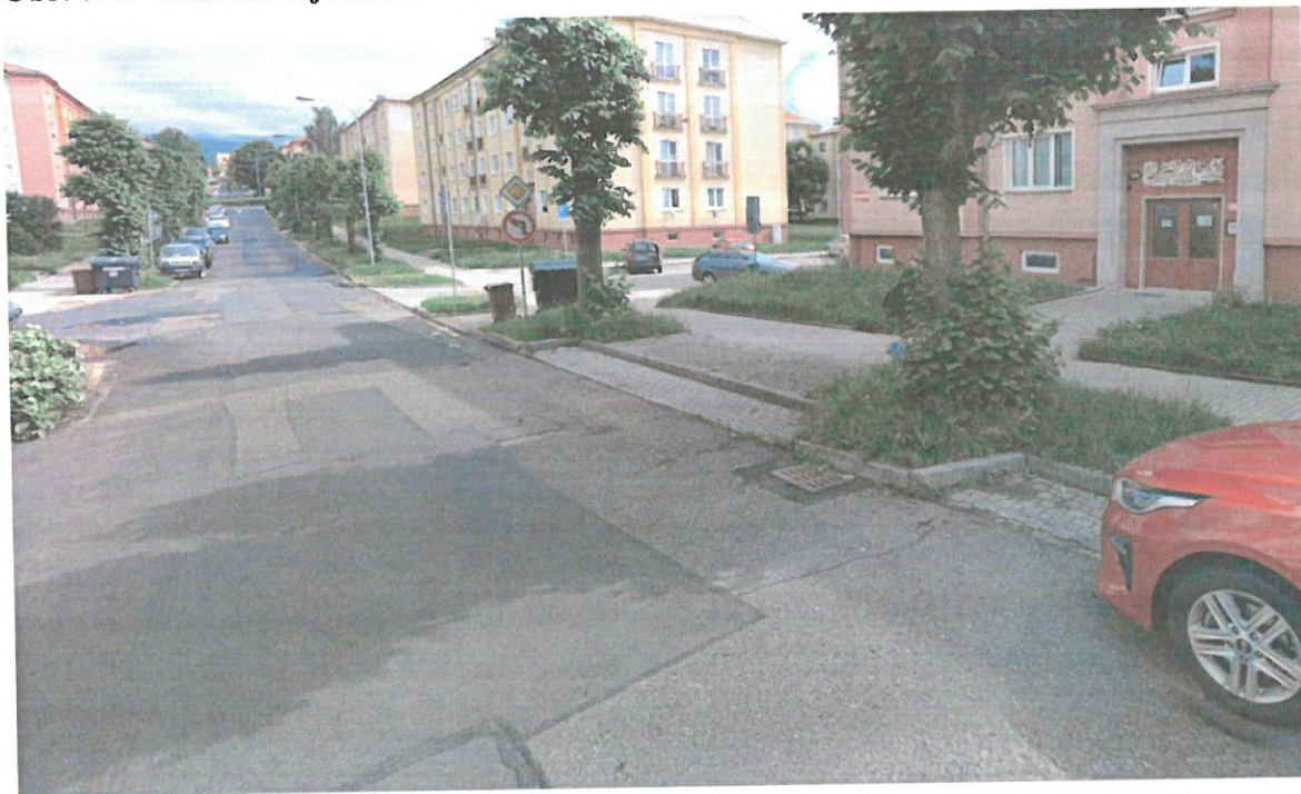
Obr. č. 1 – Foto stávající stav:
