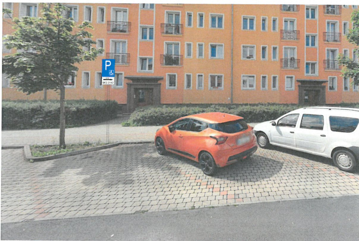
Obr. č. 3 – Foto stávající stav:
