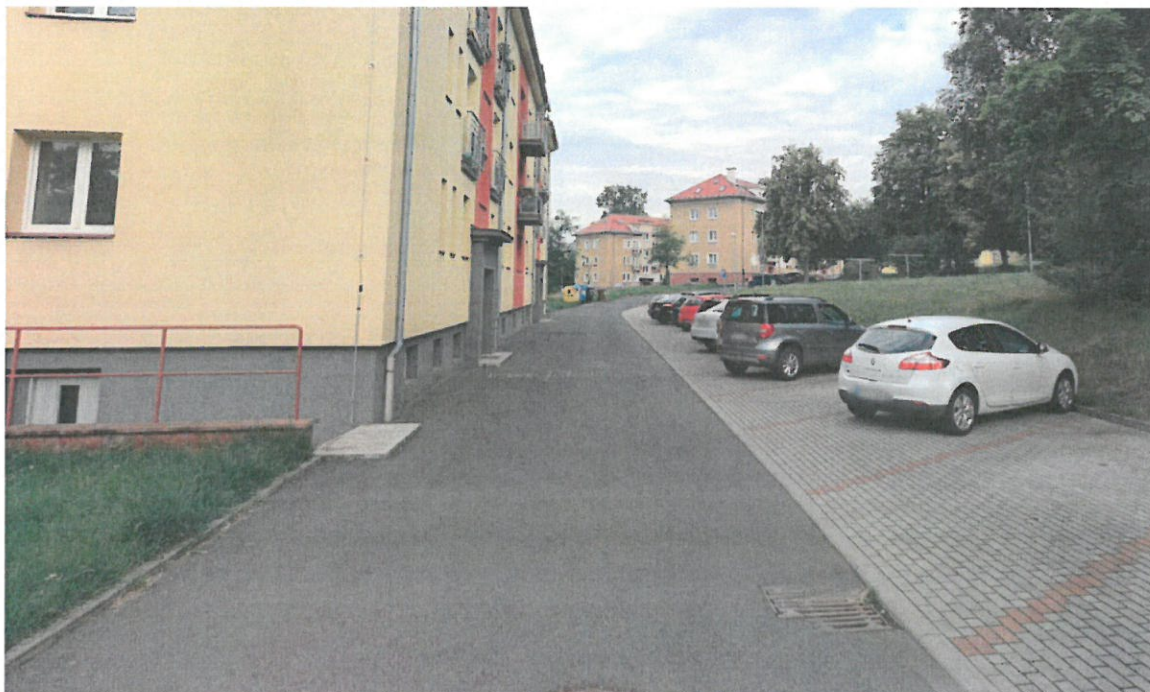
Obr. č. 3 – Foto stávající stav:
