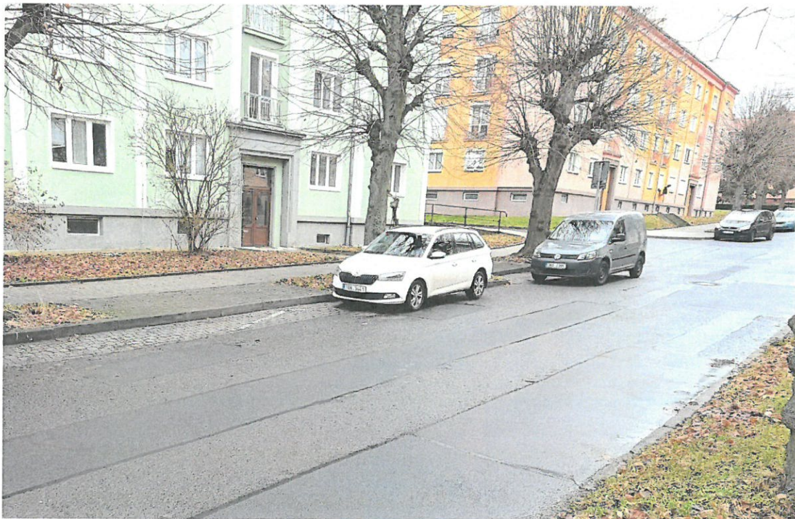
Obr. č. 1 – Foto stávající stav:
