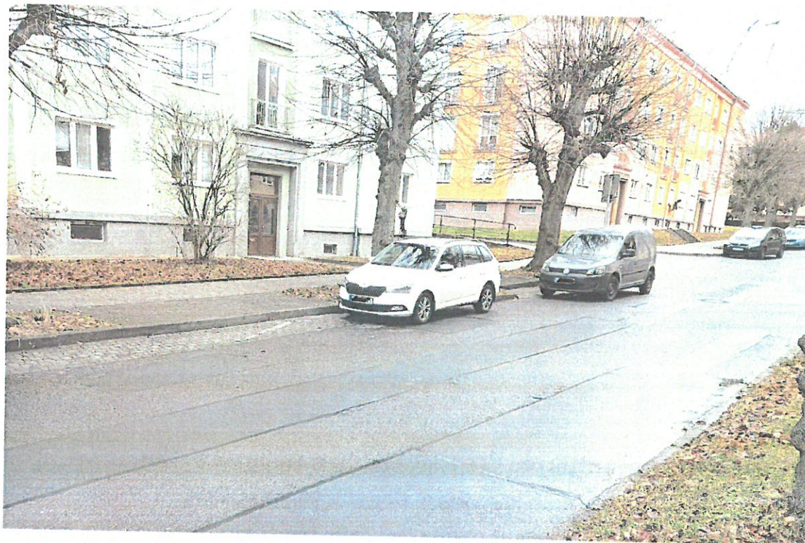
Obr. č. 1 – Foto stávající stav:
