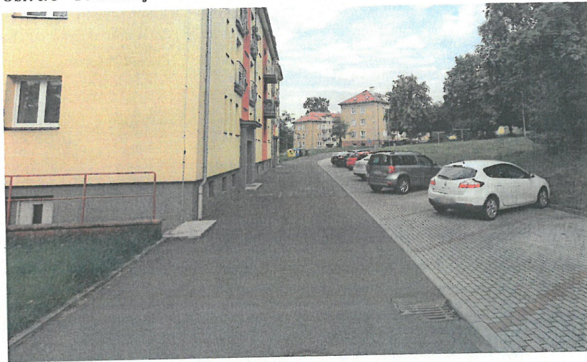
Obr. č. 3 – Foto stávající stav:
