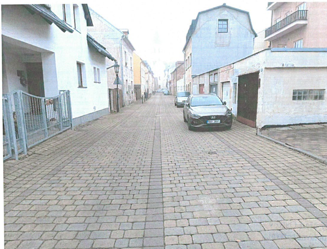
Obr. č. 6 – Foto stávající stav, zpětný pohled do Žižkovy ulice:
