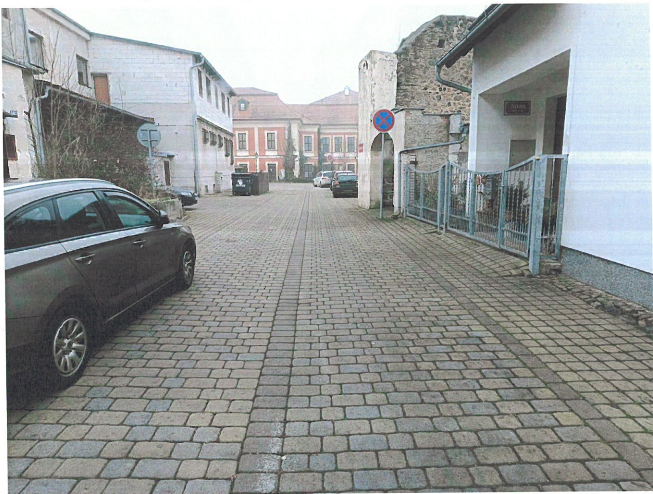
Obr. č. 5 – Foto stávající stav, konec jednosměrné komunikace:
