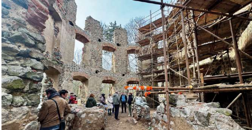
Veškeré práce na záchraně loveckého zámku u Mořčova dozoruje statik a přibližně devadesát procent použitých materiálů tvoří původní stavební prvky. Foto: Petr Jakubes
