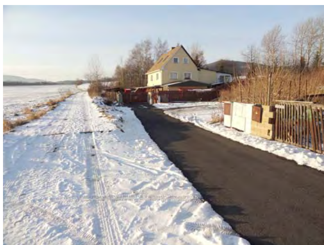
místní komunikace zahrazená majitelem rodinného domu
