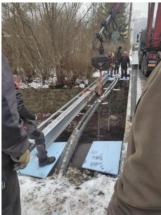
Obr. č. 62. Lávka přes Petrovský potok - oprava
